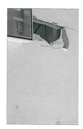
Plafones rotos, con humedad, deteriorados o faltantes. Riesgo de desplome de los plafones en mal estado o parte de ellos. Se registran sensaciones térmicas inadecuada para el estudio y la enseñanza: alta humedad y bajas temperaturas por la falta o rotura de los plafones que sirven como aislantes térmicos. Se requiere su sustitución y corrección.
