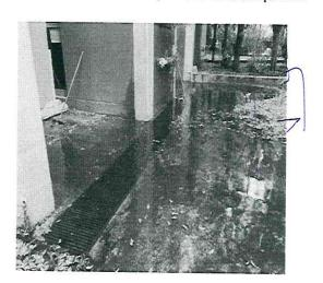
Pasando la caseta de la entrada principal, hacia adentro, cuando la lluvia es más o menos nutrida se genera esta anegación que obliga a quienes ingresan a evitar el contacto con el agua con el riesgo correspondiente. Se requiere que se destapen los conductos por donde debe correr el agua que aquí se acumula.
