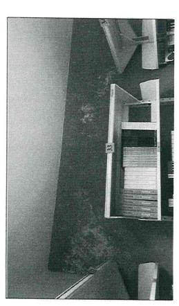
Filtraciones de agua -a chorros en algunas ocasiones- humedad en techos y paredes. Presencia de hongos y moho. Acumulación de hojarasca sobre la techumbre del edificio "A", así como en las canaletas y tuberías de desagüe de dicha techumbre. Se registra en cubículos de estudio, cubículos de DTI, biblioteca, pasillos,
