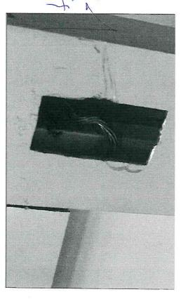
La práctica totalidad de los cubículos de estudio tienen instalaciones eléctricas rotas, en mal estado, deficientes, con cableado expuesto o sin interruptor. Riesgo de electrocución para estudiantes, DTI y personal de limpieza. Se requiere se arreglen las instalaciones eléctricas de los cubículos de estudio; lo que incluye interruptores nuevos y tapas.
