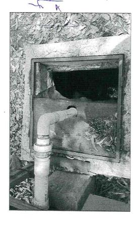
almacena agua que sirve para completar la distribución del líquido que llega a diferentes partes de En la entrada principal, del lado derecho, esta cisterna está destapada en sus dos acometidas de la preparatoria y al estar expuesta, entran diversos tipos de contaminantes, el otro riesgo es que manera permanente, implica los siguientes riesgos y áreas de oportunidad, en esa cisterna se alguien pueda caer en la cisterna. Se requiere que se limpie y se cierre con candados
