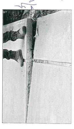
En pasillo de acceso a los edificios "A" y "B", lajas de concreto desniveladas por crecimiento de raíces de un árbol, implica el riesgo de caída de la cualquier miembro de la comunidad del plantel. Se requiere el levantamiento, de las lajas , el corte de raíces y la colocación adecuada de las lajas o en su defecto un colado nuevo de lajas.
