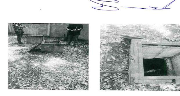
En la entrada principal, del lado derecho esta cisterna está destapada de manera permanente, implica dos problemas al menos, en esa cisterna se almacena agua que sirve para completar la distribución del líquido que llega a diferentes partes de la preparatoria y al estar expuesta, entran diversos tipos de contaminantes, el otro riesgo es que alguien pueda caer en la cisterna. Se requiere que se limpie y se cierre.
